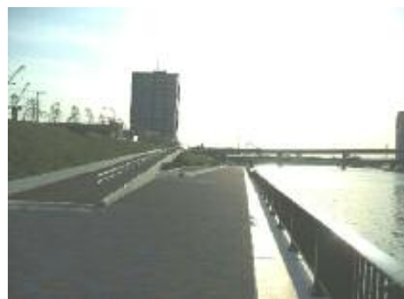
造成中のスーパー堤防
