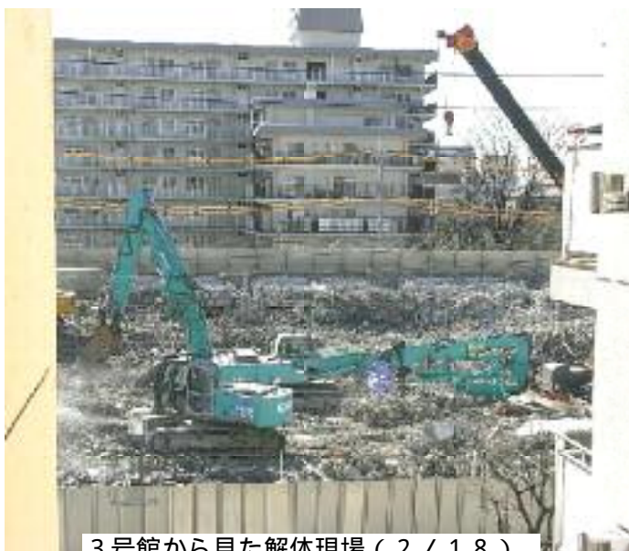
3号館から見た解体現場(2/18)
