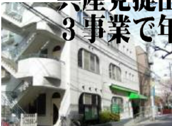
西日暮里在宅高齢者通所サービスセンター
