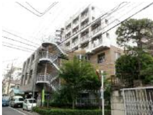
町屋7丁目・区立高齢者住宅
