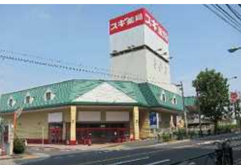
空き店舗状態の建物(スギ薬局もすでに撤退)
