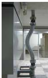
配管は、揺れても壊れない仕組みに。明る くなった地下ホールと揺れ幅の注意書き。
