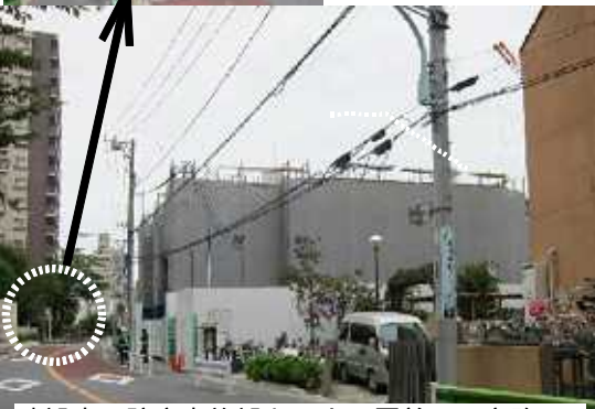
建設中の障害者施設とルネ町屋前のT字路
