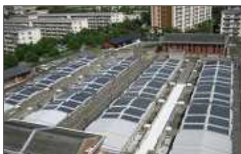
上は、名古屋市銅屋上野浄水場の太陽光発電システム
