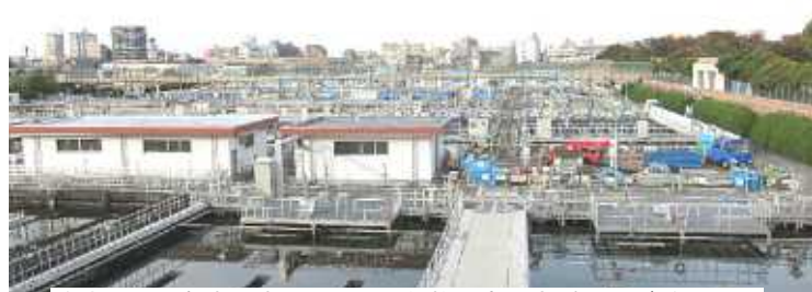
広大な三河島水再生センター 何枚の太陽光パネルが乗るか？
