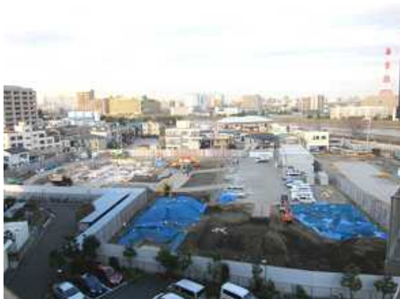
町屋7丁目特養ホーム工事現場
