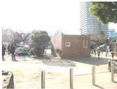
給水槽（飲料水）のある日暮里南公園（1500ト）規模）...正面建物
