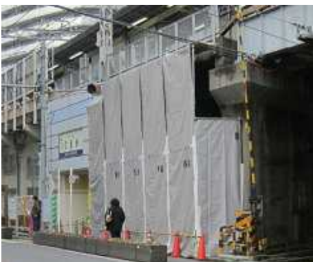
工事中の京成町屋駅舎
