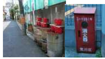
上は、二峡小プール側のドラム缶とバケツ、配備している消火器 右は拡幅された二峡小側の道路
