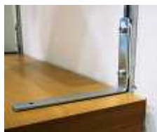
中越地震で家具が転倒した室内 L字金具で固定した家具
