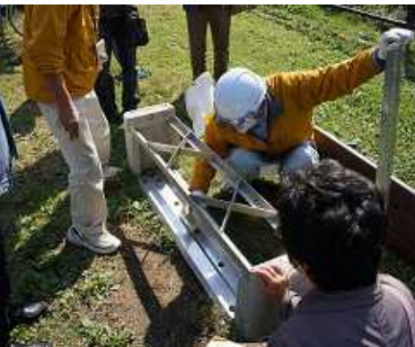
マンホールトイレ(上)とかまどベンチ(下)のセッティング風景
