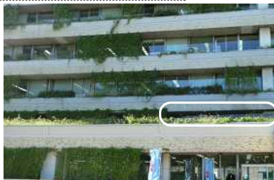
上は、共産党控室外の緑のカーテン。下は本庁舎正面の緑のカーテンと下白枠内に太陽光発電パネル設置
