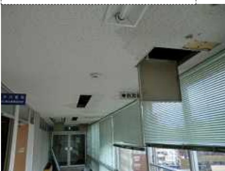
通路枝の窓側に雨漏り、水漏れした天井は、修理の途中です。
