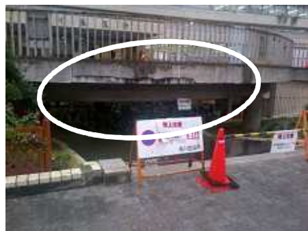
落下物防止の金属の覆い(上) 区役所正面の通行止めとセメント剥離跡
