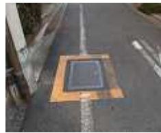
地下式消火栓は、オレンジの枠で表示左。吸水は右写真のように
