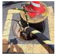
地下式消火栓は、オレンジの枠で表示左。吸水は右写真のように
