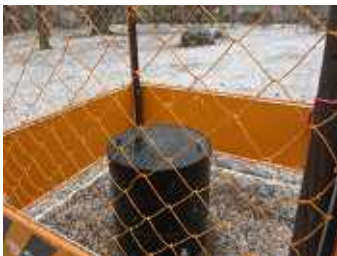
工事中の深井戸
