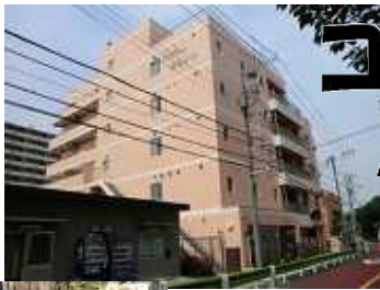
上・左は、バス停予定地近くの障害者施設スクラムあらかわ前の歩道、狭く段差も多い…一刻も早く改善を
