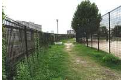
公園拡張用地全景と耐震化される堤防
